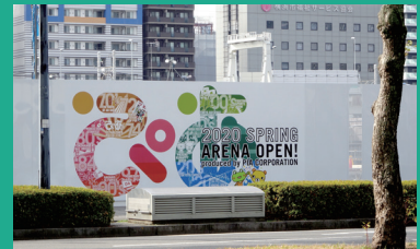
首都高速神奈川1号横浜線沿い、大きなびあロゴがデザインされた仮囲いの場所が完成予定地
